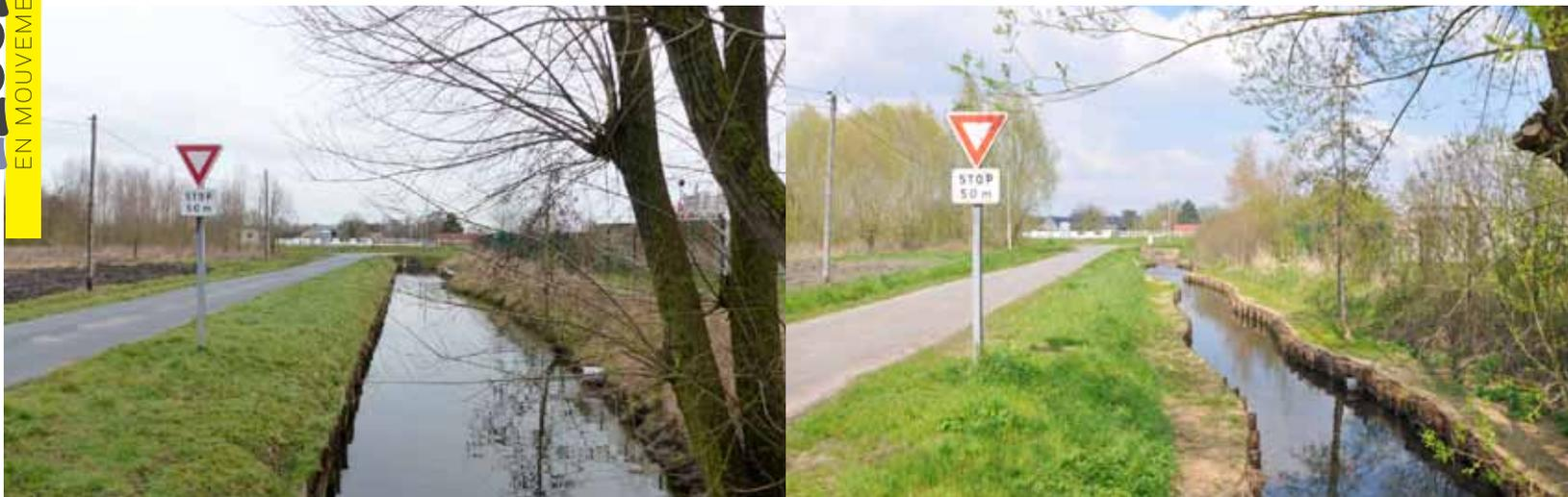
Avant / Après : des travaux de restauration du lit mineur de la Loisme ont été menés à Beuvry (réduction de la largeur du lit du cours d'eau et création de méandres pour modifier la vitesse d'écoulement de l'eau).
