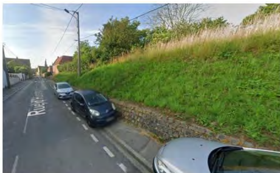
5-Aperçu de la forte déclivité du terrain
