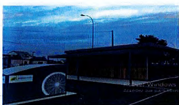
Figure 31: 3- Pôle d'échanges multimodal (Équipements complémentaires à l'existant en gare ou abris ferme et sécurisé de 50 places)
