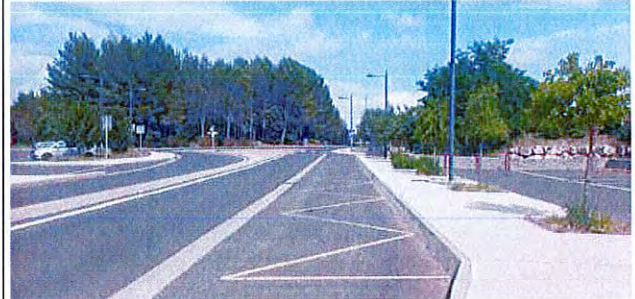
Figure 47: Nouvel arrêt de bus
