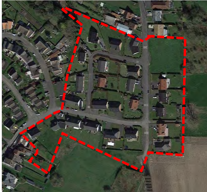
Vue aérienne de la zone 1AUa
