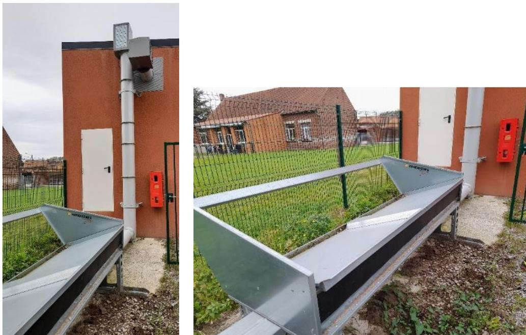
*Système de remplissage du silo et d'alimentation de la chaudière par vis de remplissage*
