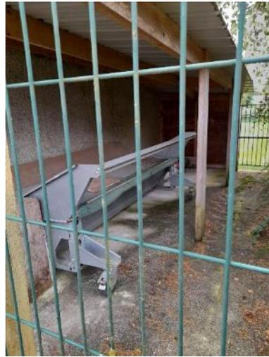
*Système de remplissage du silo et d'alimentation de la chaudière par vis de remplissage*
