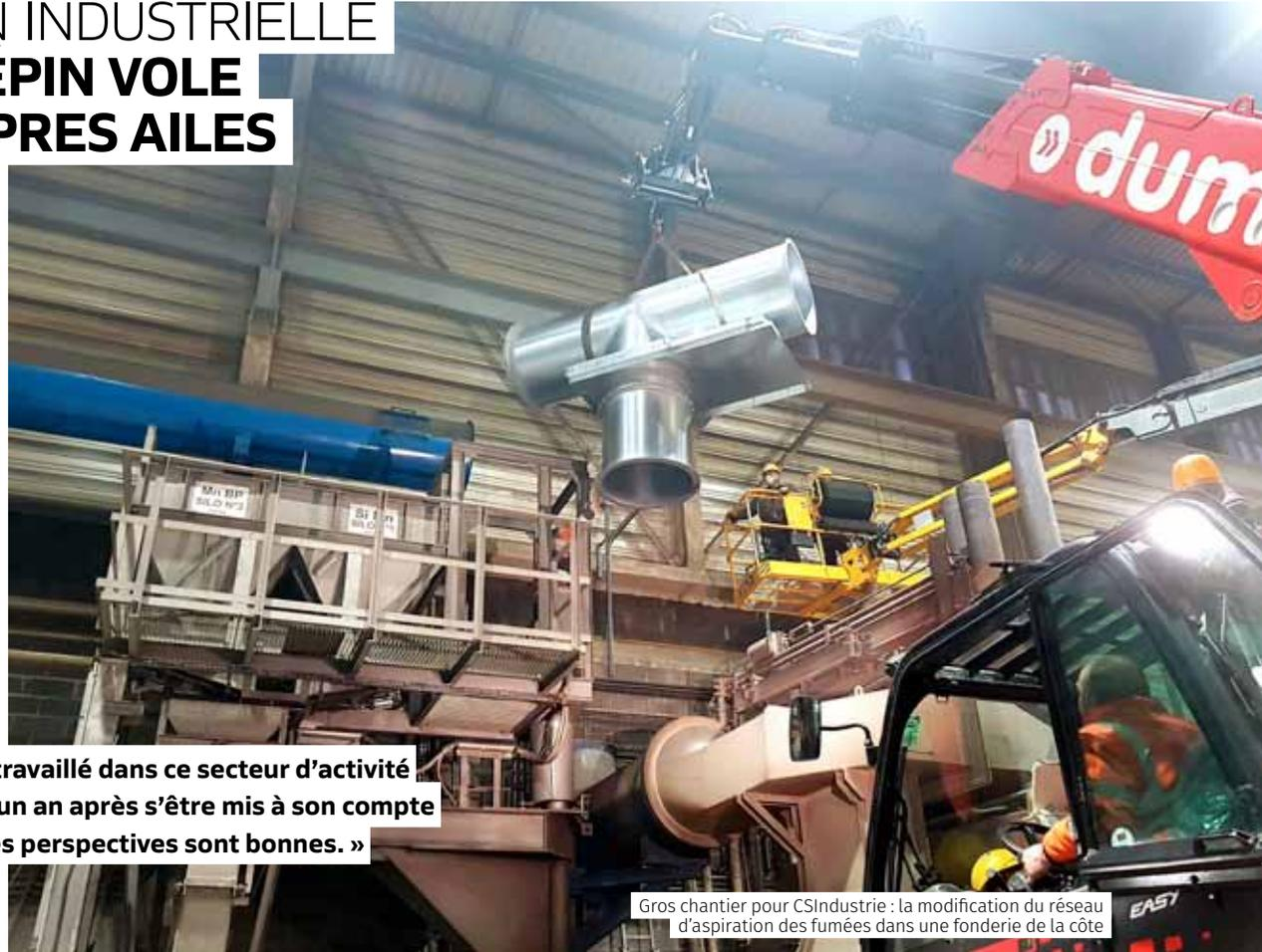
Gros chantier pour CSIndustrie : la modification du réseau d'aspiration des fumées dans une fonderie de la côte
