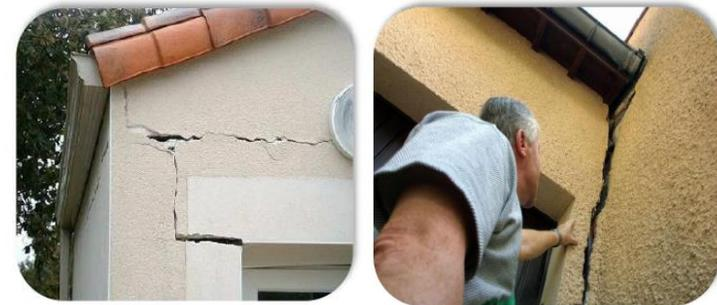
Figure 39 : exemple de dégâts causés par le retrait gonflement des argiles sur l'habitat (Source groupe SMA – photo de gauche – et MEDD – photo de droite)
