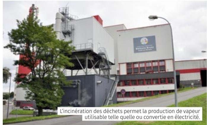
L'incinération des déchets permet la production de vapeur utilisable telle quelle ou convertie en électricité.
